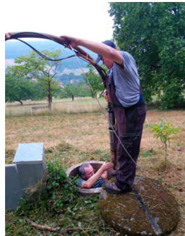
Reparaturarbeiten am Hausbrunnen
